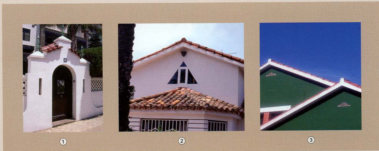
► Tres ejemplos de pintaderas como sistema de aireación. La imagen izquierda muestra la fachada almenada de la Casa Larrarte de Santa Cruz (1942). Los otros dos ejemplos están en el término municipal de La Laguna, construidos en décadas posteriores a Marrero Regalado, siendo elementos arquitectónicos que han perdurado en las construcciones canarias hasta la actualidad.
